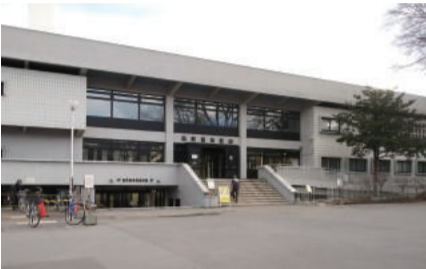
(上) 改修が行われているクラーク会館
