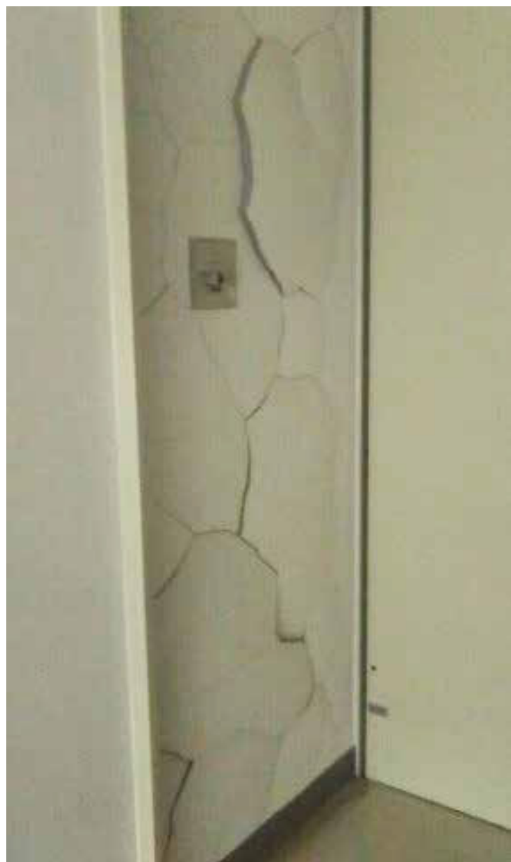
廊下の壁がひび割れた（経済学部棟、施設部提供）
