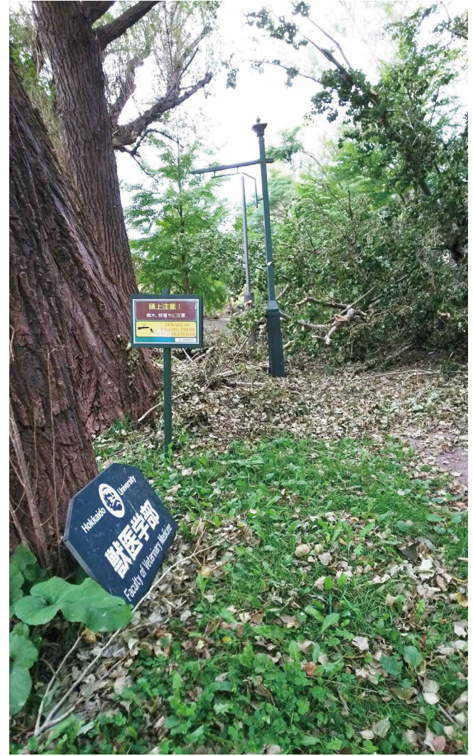
看板が落下した（9月10日、獣医学部付近）
