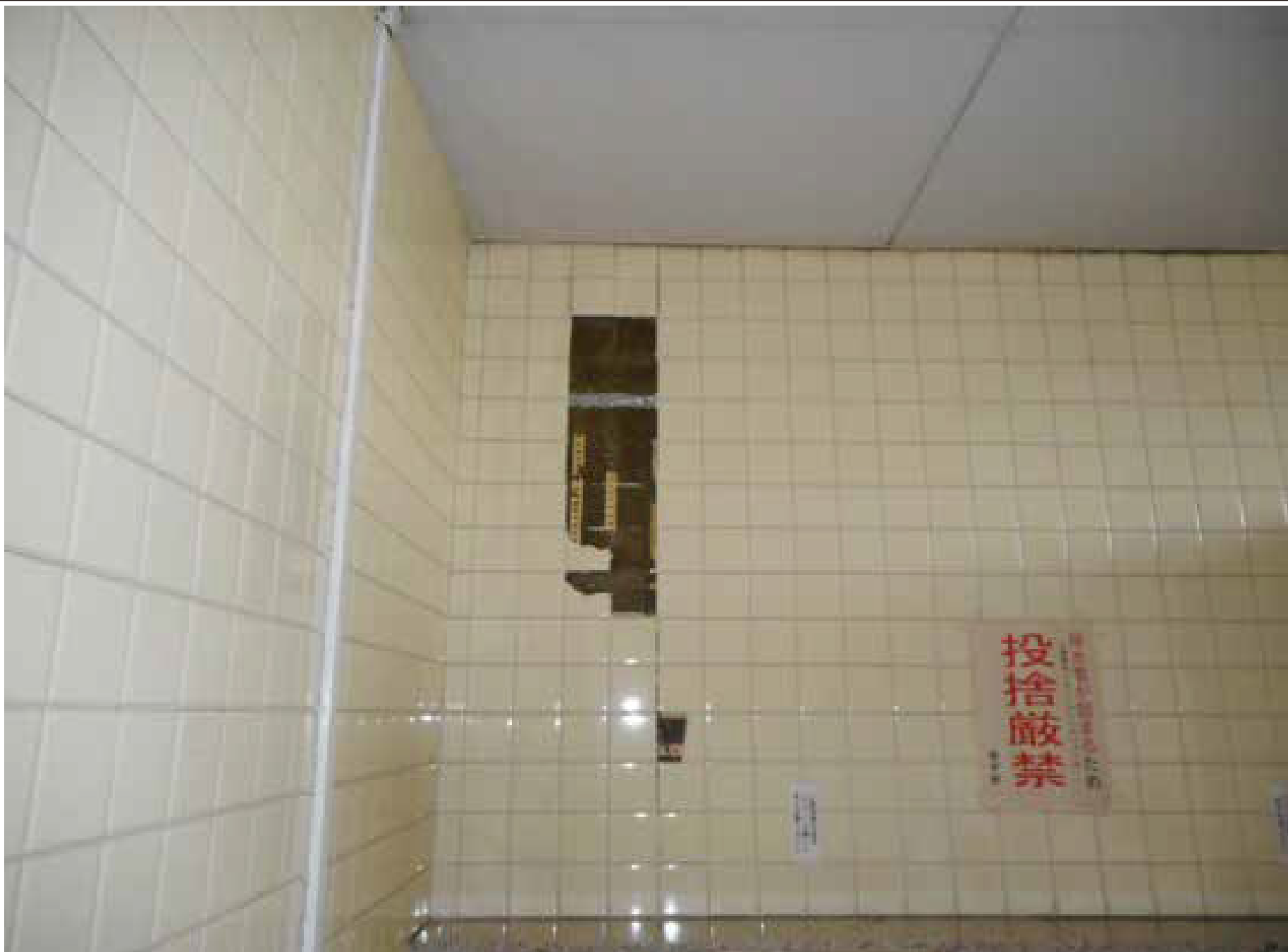
壁のタイルが剥がれ落ちた（歯学部 A 棟トイレ内、施設部提供）
