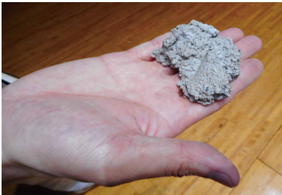
落下したモルタル片（クラーク会館講堂、施設部提供）
