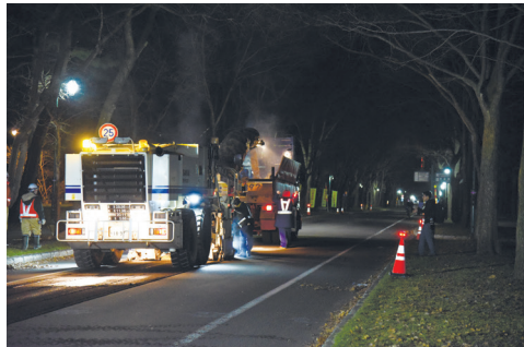
大型の路面切削機で削った(16日、北図書館付近)
